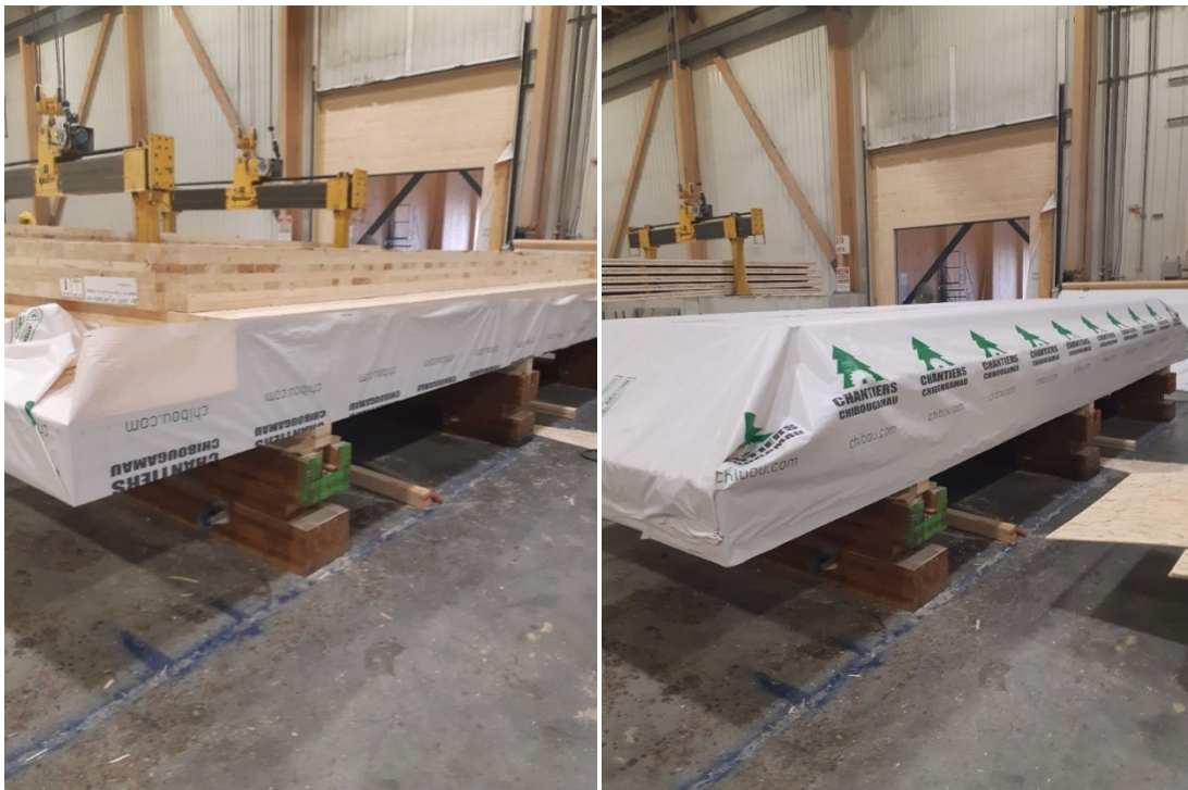
Figure 4.4 L'emballage de protection est ensuite replié sur les panneaux et agrafé.
