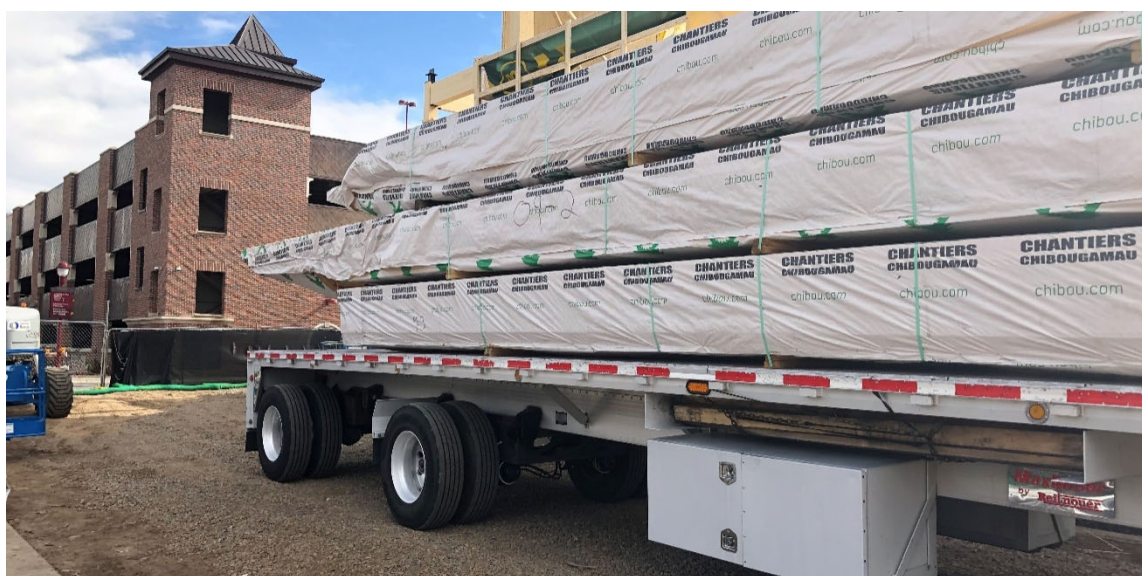
Figure 4.8 Un pont roulant ou un chariot élévateur à fourche est utilisé pour charger les colis sur les camions.
