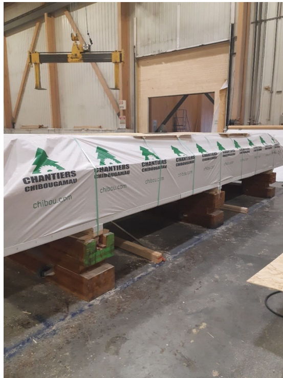
Figure 4.6 L'ensemble du paquet, y compris le bloc de bois qui maintient le bois lamellé-croisé en position élevée, est ensuite attaché.
