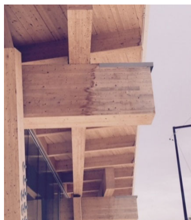
Figure 6.2 Cernes d'eau causés par la lixiviation inégale des matières extractives
