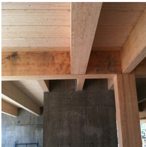
Figure 6.1 Tache de béton laissée lors de la coulée du béton
