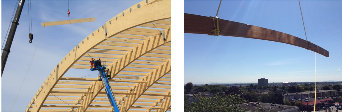
Figure 5.3 Levage des poutres Lam+ à l'aide d'une grue
