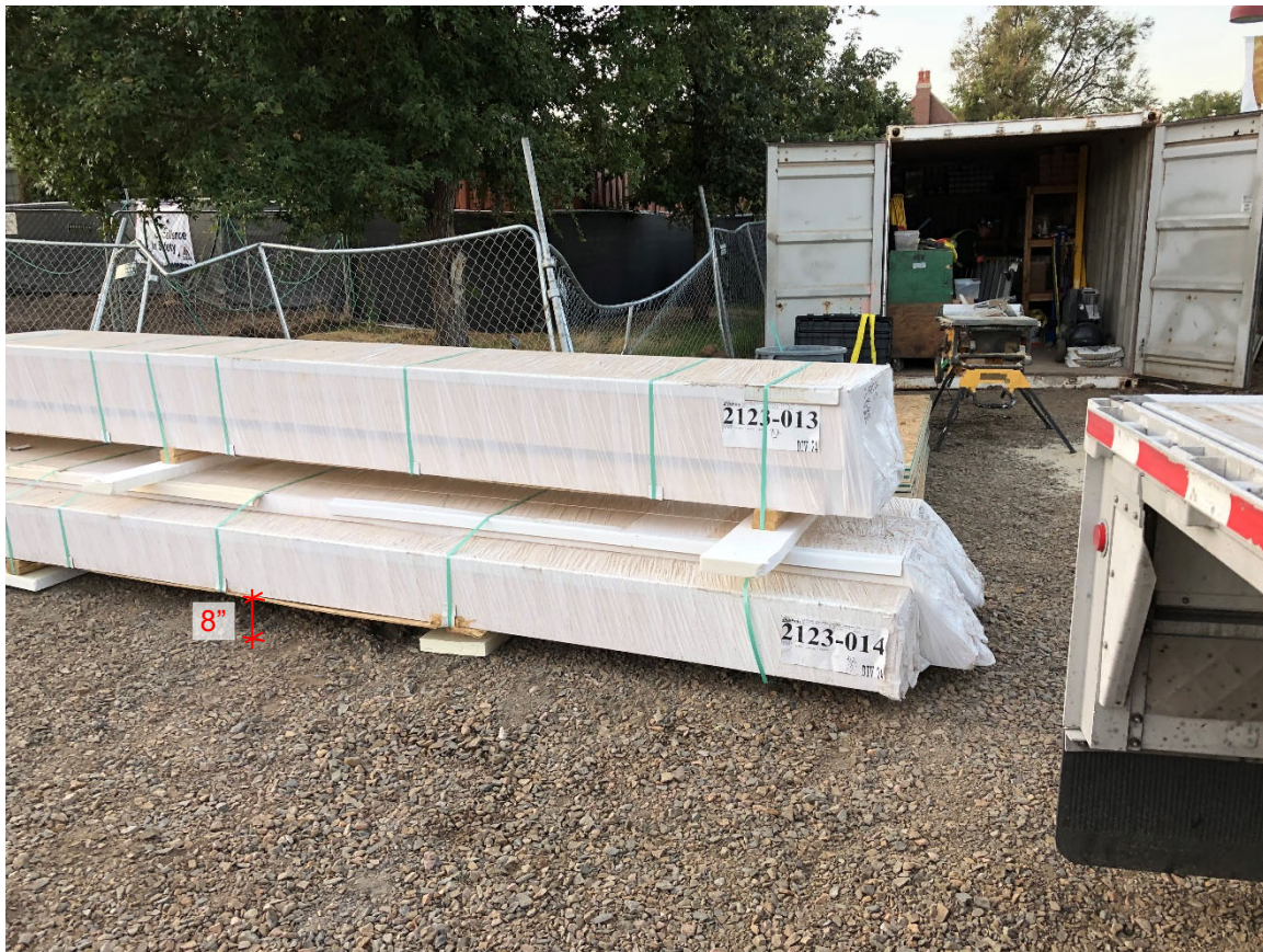
Figure 4.17 Entreposage adéquat des produits sur des blocs de bois pour assurer une bonne circulation d'air
