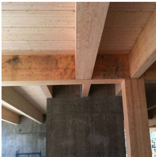
Figure 6.1 Tache de béton laissée lors de la coulée du béton au-dessus
