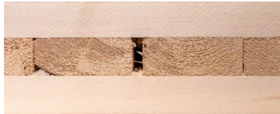
Figure 2.4 Interstices entre les lamelles adjacentes dans une couche centrale
